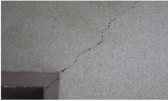
ひび割れた壁
