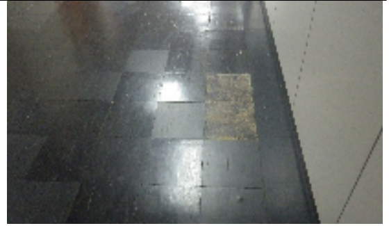
剥がれている床タイル
