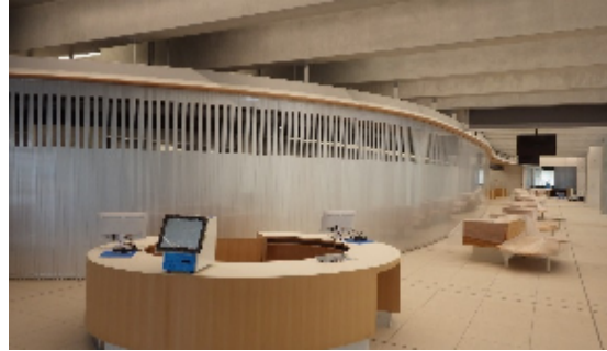
防犯シャッターによる執務室の隔離（閉庁日等）
