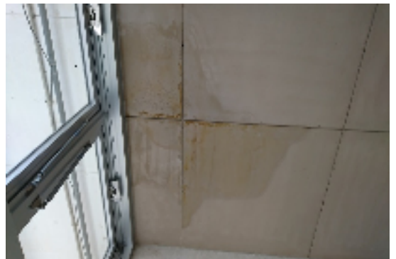
天井の雨漏りの跡②
