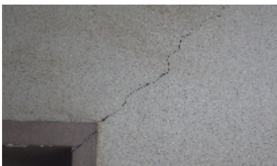
ひび割れた壁
