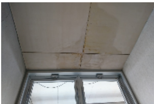
天井の雨漏りの跡①
