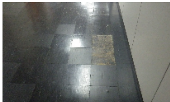
剥がれている床タイル
