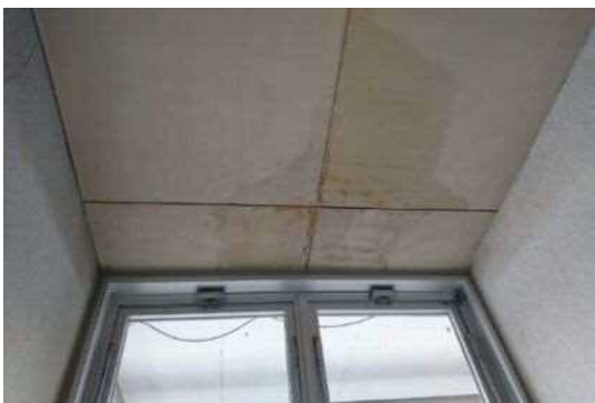
天井の雨漏りの跡①
