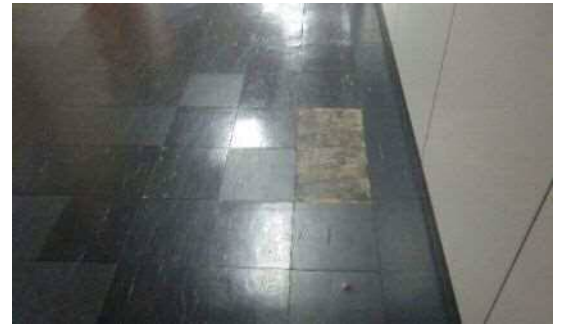
剥がれている床タイル
