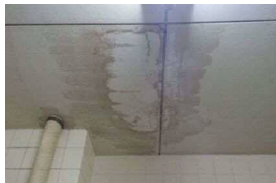
天井の雨漏りの跡②
