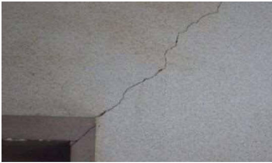
ひび割れた壁
