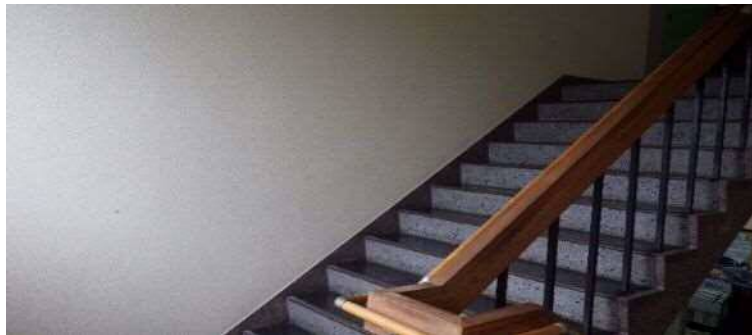
両側に手すりの無い階段
