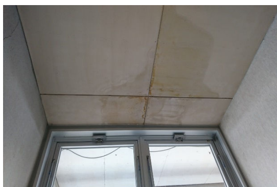
天井の雨漏りの跡①
