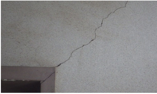
ひび割れた壁
