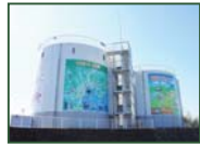
【須賀崎避難場所】 配水池 海拔24.0m
