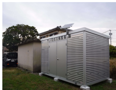
草川小学校備蓄倉庫
