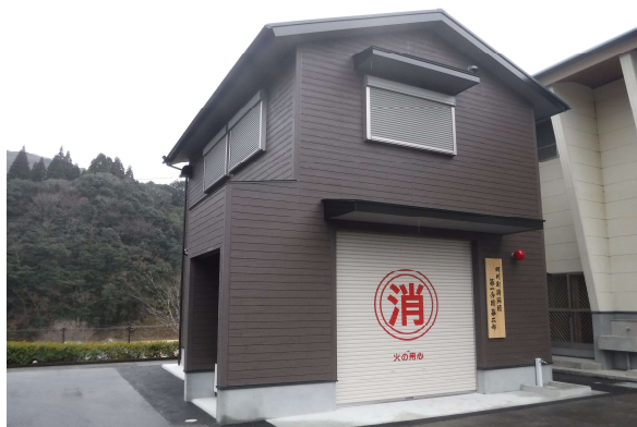
台風時の大雨で機庫が浸水被害にあったことから、西門川地区活性化センター横の高台に移設した消防団第2部機庫
