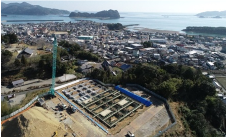
平城東の高台に建設が進む役場新庁舎（令和 2 年 1 月現在）
