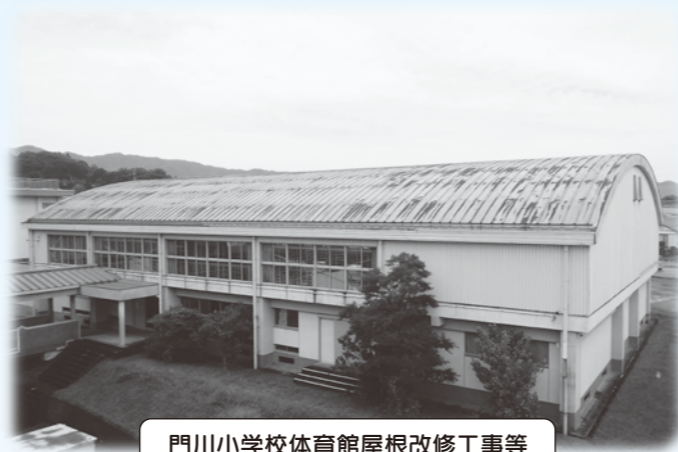
門川小学校体育館屋根改修工事等 2811万2千円
