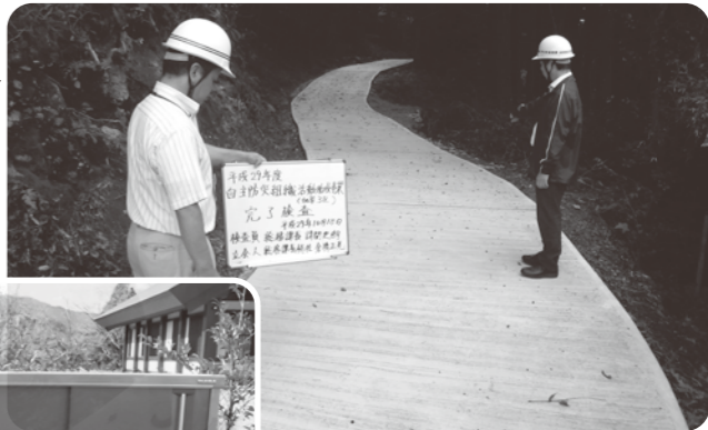
加草3区 避難道路舗装
