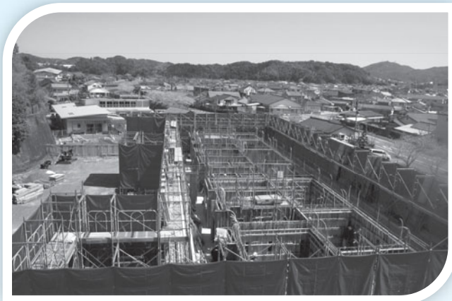
栄ヶ丘団地町営住宅 D棟建設事業
