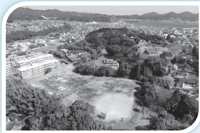
新庁舎建設予定地
