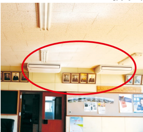
空調機（室内機）
