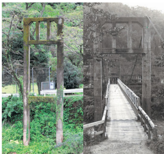
(左写真) 現在の旧松瀬橋の跡。松瀬大橋のすぐ隣にあります。
