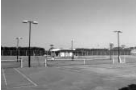
テニスコートに夜間照明設置
