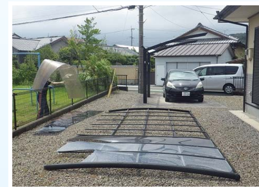
台風8号の強風で飛散したカーポート
