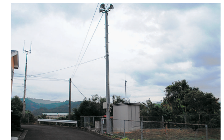
城ヶ丘区放送設備
