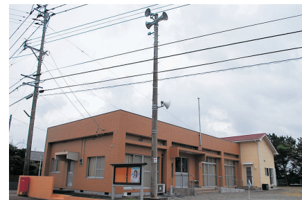
南町二区自治公民館放送設備
