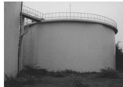
門川配水池（2号タンク）
