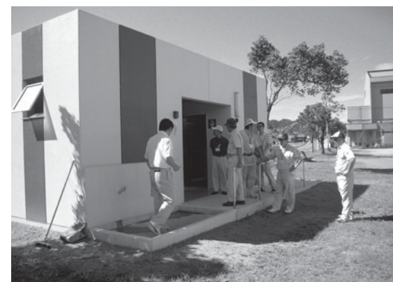
南町近隣公園トイレ設置工事
