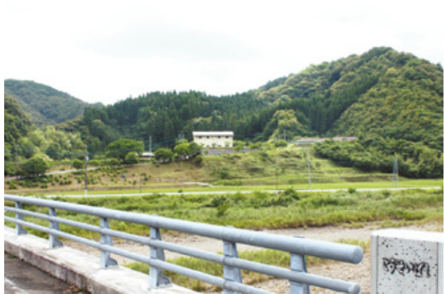
平常時の更生橋
