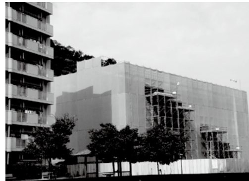
栄ヶ丘団地 町営住宅建替事業 (栄ヶ丘町営住宅)
