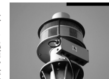
モーターサイレン 異常時にサイレンを吹鳴します。
