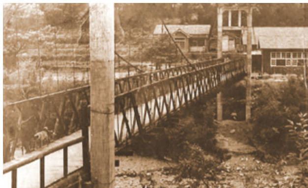
昭和52年頃の松瀬地区のつり橋です。現在は取り壊され、両端の主塔が残るのみです。
