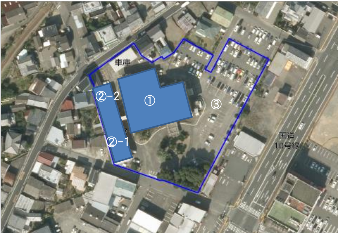
<庁舎跡地全体>
