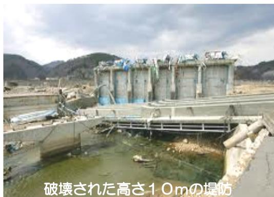
破壊された高さ10mの堤防
