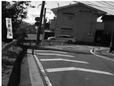
▲永願寺下急カーブ危険箇所
