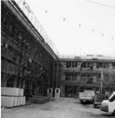
門川中学校の改築現場
