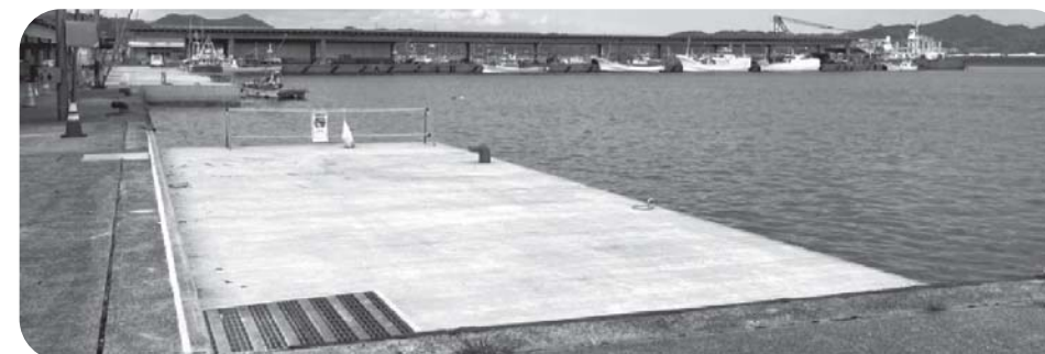
門川漁港内 水産基盤整備事業
