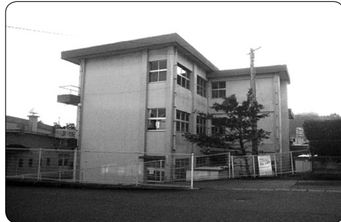
緊急避難所予定の門川小学校
