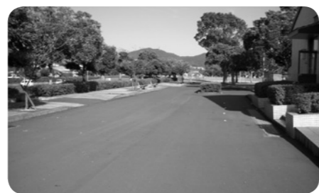
海浜公園内園路改修工事
