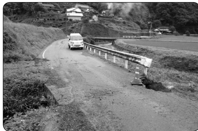
災害復旧工事箇所
