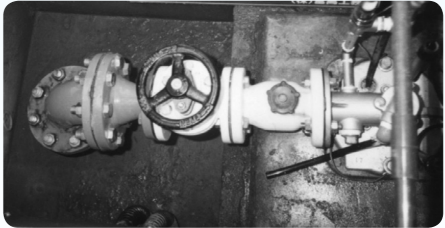
大原地区簡易水道取水ポンプ取替工事
