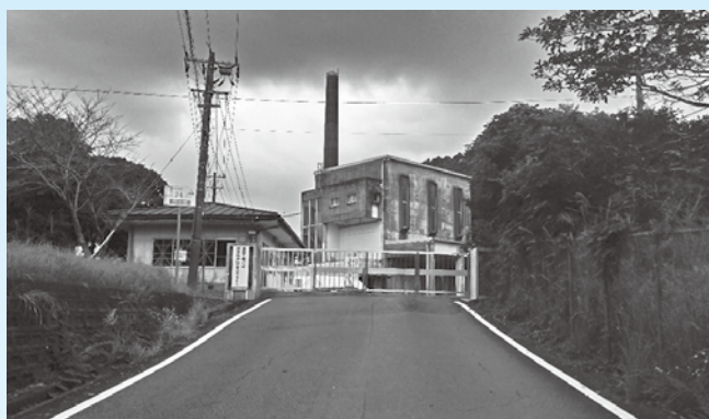
門川町清掃工場
