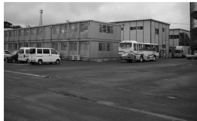
山元町役場仮設庁舎：庁舎は地震により使用できない状態
