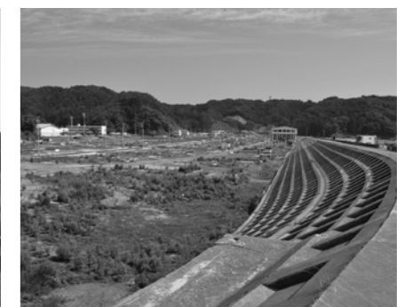
宮古市田老地区：津波は、写真右側のスーパー堤防(高さ10.5m)を乗り越えて写真左側の住宅地に流れ込んだ。
