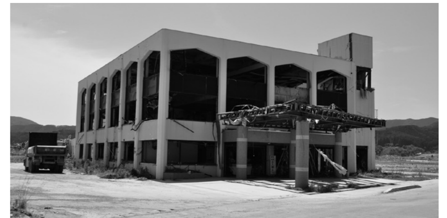
陸前高田市市民会館：三階まで水没、避難していた多くの市民が亡くなった。
