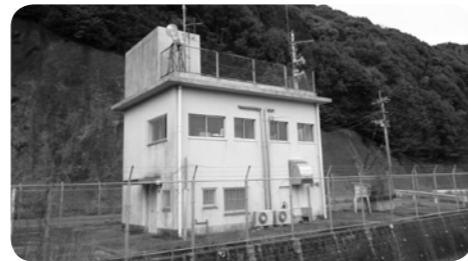
中村防災ダム管理棟
