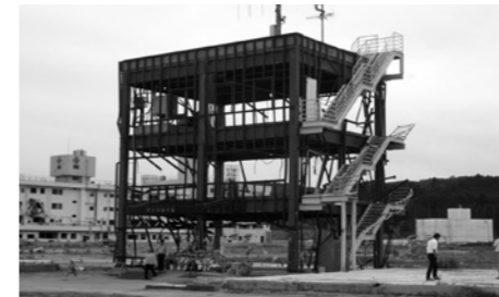
南三陸町防災庁舎：鉄骨部分のみが残る。
