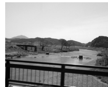
陸前高田市：河口から約5km上流にあるJR大船渡線の鉄橋が津波により流失
