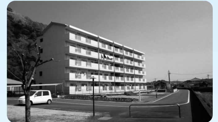
栄ヶ丘団地町営住宅D棟建設事業 写真はC棟
