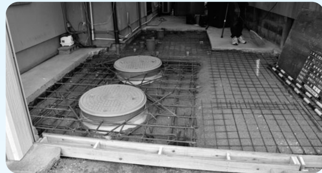
浄化槽設置工事 補助事業
