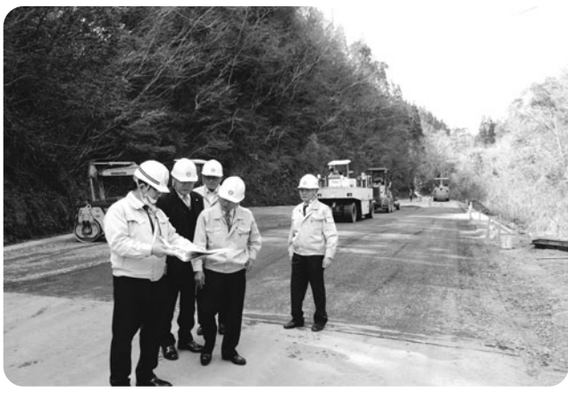
工事が進む松瀬・川水流線の現地調査
