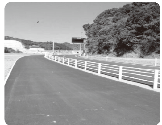
奥が門川南スマートインターチェンジ
