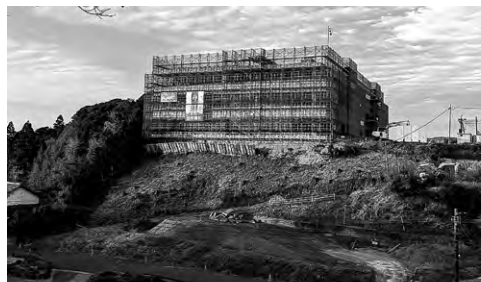
▲建設中の新庁舎
