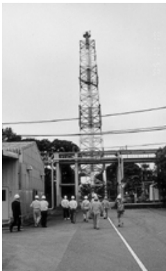
撤去される煙突
