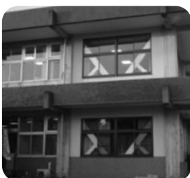
耐震補強工事をした庁舎
