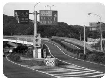
延岡南道路入口（国道10号線）
