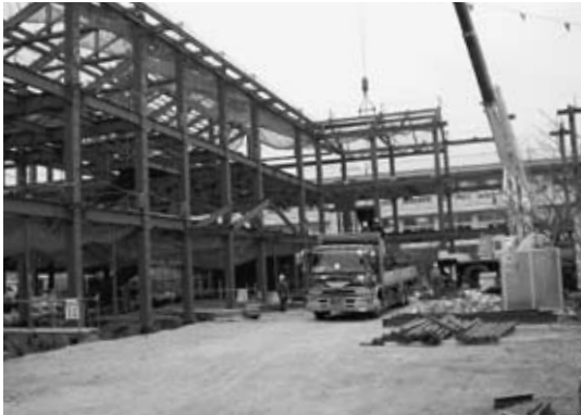
建設が進む門川中学校校舎
