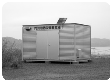
心の杜にある備蓄倉庫
