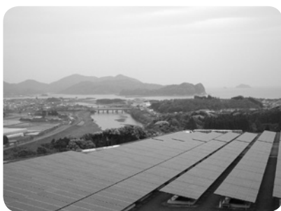
工事が進む太陽光発電
