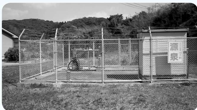
心の杜 源泉ポンプ交換
