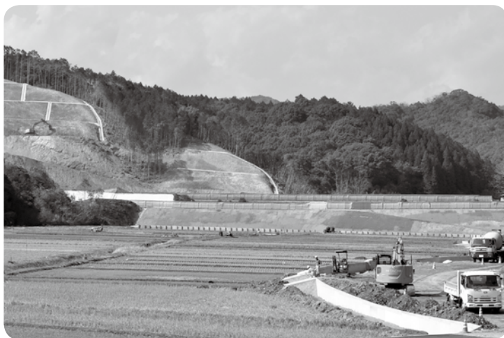
工事が進むスマートインター
