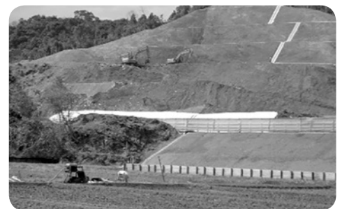
インター法面工事
