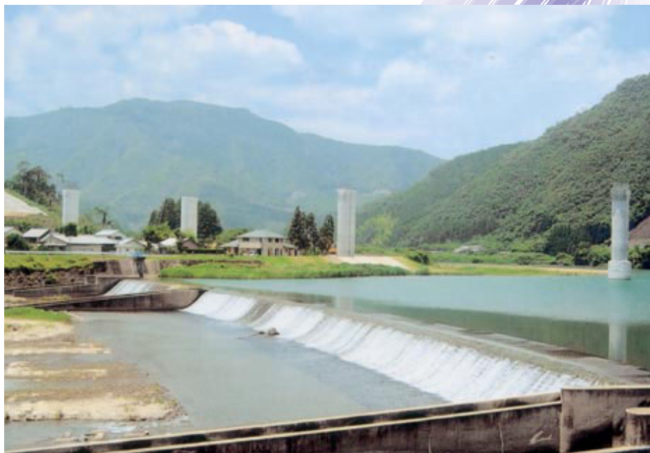
東九州自動車道橋桁
