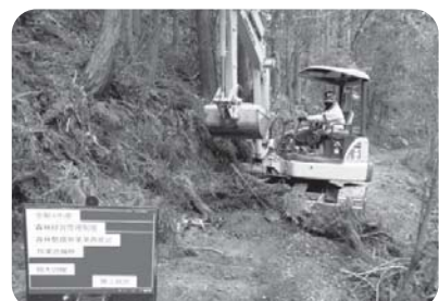
▲森林経営管理制度 作業道補修
