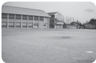
排水対策が図られる門川中学校運動場
