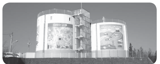
加草に設置されている配水タンク
