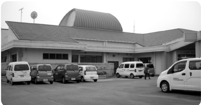
総合福祉センター(雨漏り補修・空調設備交換等)
