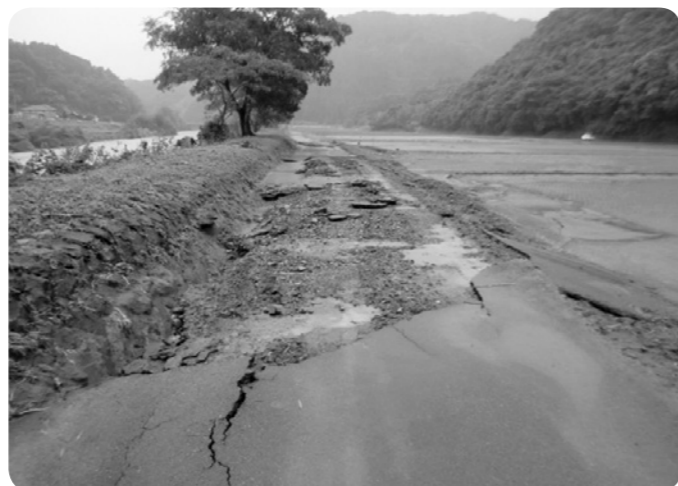
上井野・神舞線舗装復旧(補正)
