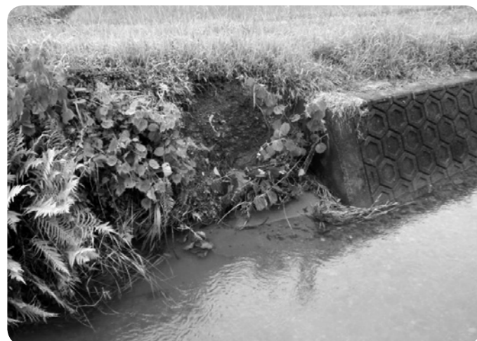
丸バエ川護岸復旧(補正)
