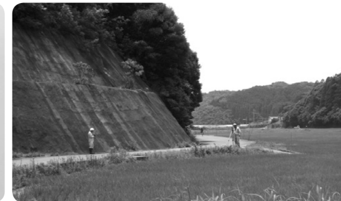
測量が進む門川南スマートインター 事業費6370万円
