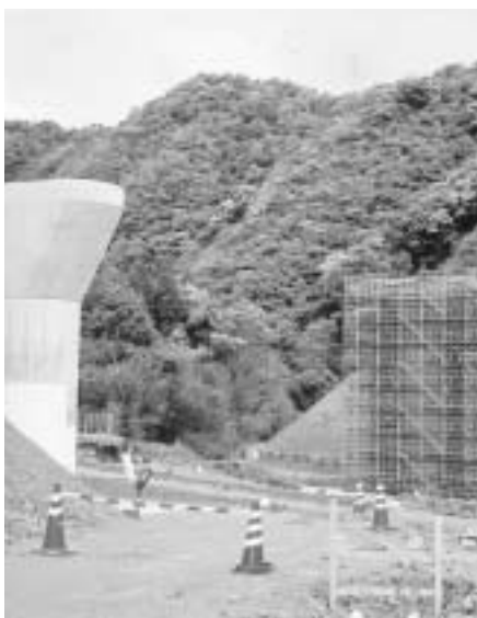
自動車道建設現場（小園）
