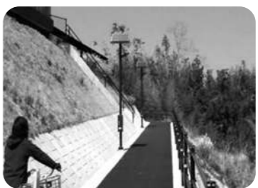
▲公的整備の緊急避難通路
