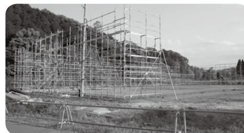
建造中のミニトマト集出荷施設
