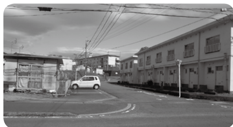
新庁舎への取り付け道路入り口
