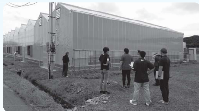
▲城屋敷ハウス施設の完成調査
