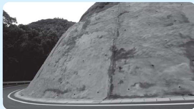
▲改良工事完成後の曾根米ノ山線道路
