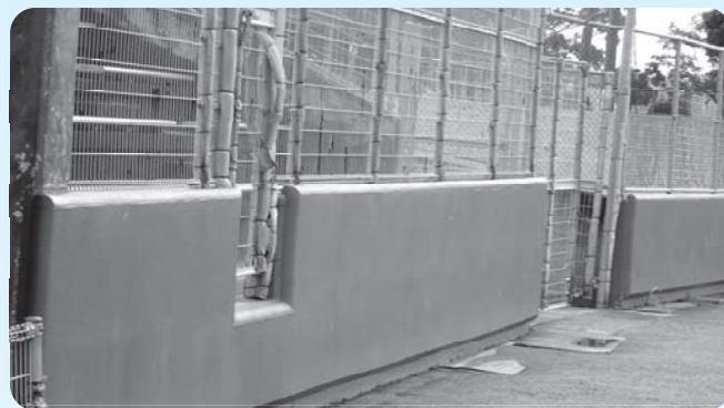
▲改修された海浜公園野球場ラバーフェンス
