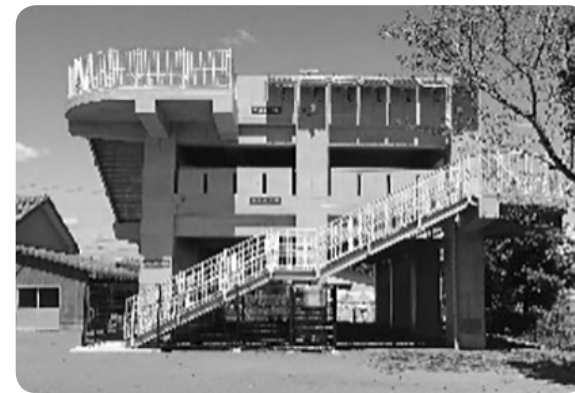
長江避難タワー(日向市)
