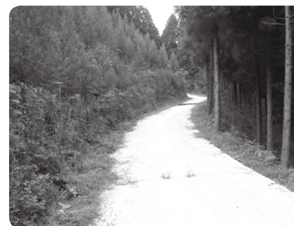
林道(作業道)舗装事業
