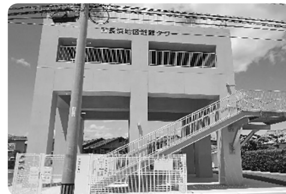
長浜地区避難タワー(延岡市)
