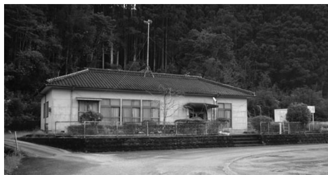
放送施設整備予定の松瀬地区集落センター
