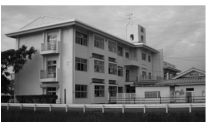
外壁塗装工事が完了した草川小学校
