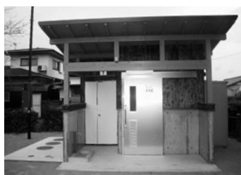
公園に設置されたトイレ(東栄町児童公園)
