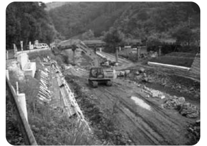
工事が進むトビノ木橋（三ヶ瀬川）
