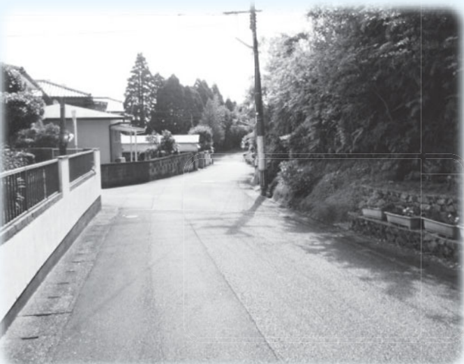
道路新設改良事業…南ヶ丘山ノ口線
