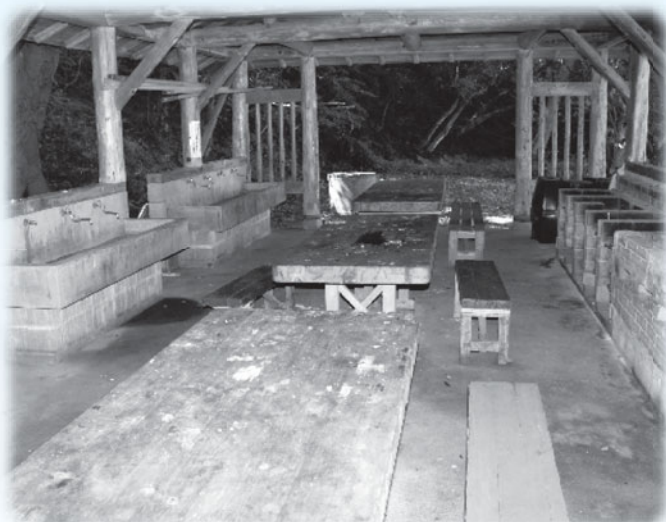
乙島キャンプ場 改修工事（現在の炊飯棟）
