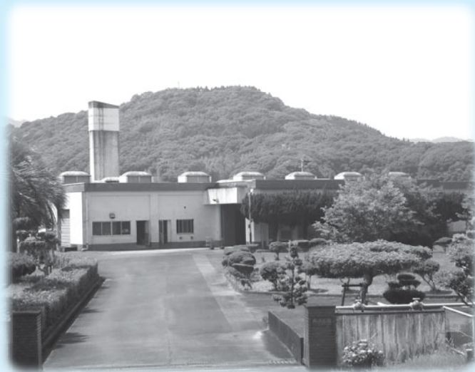
衛生センター施設整備事業（内部設備ほか）
