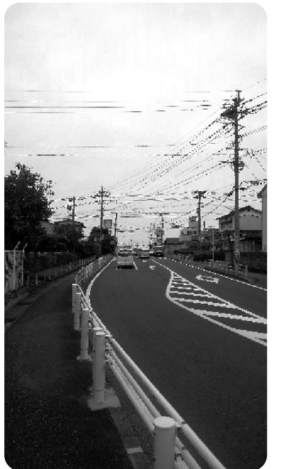
防犯カメラが設置してある交差点（東栄町）
