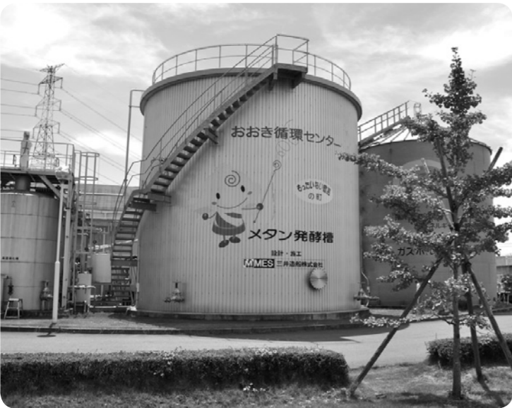
「くるるん」メタン発酵槽
