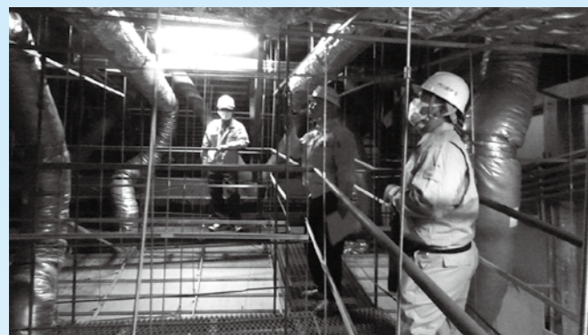
文化会館ホール天井裏
