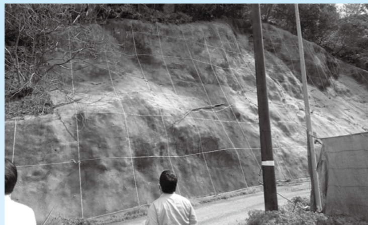
竹名中村線法面補修工事予定場所
