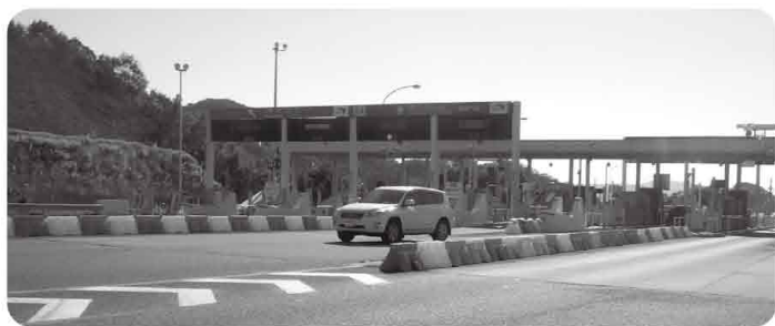
延岡南道路(門川料金所)
